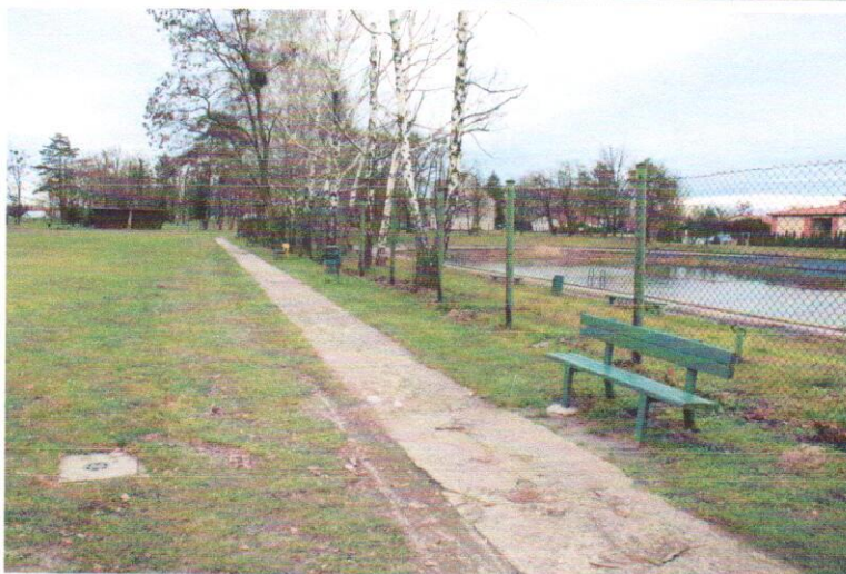
Istniejący chodnik betonowy
