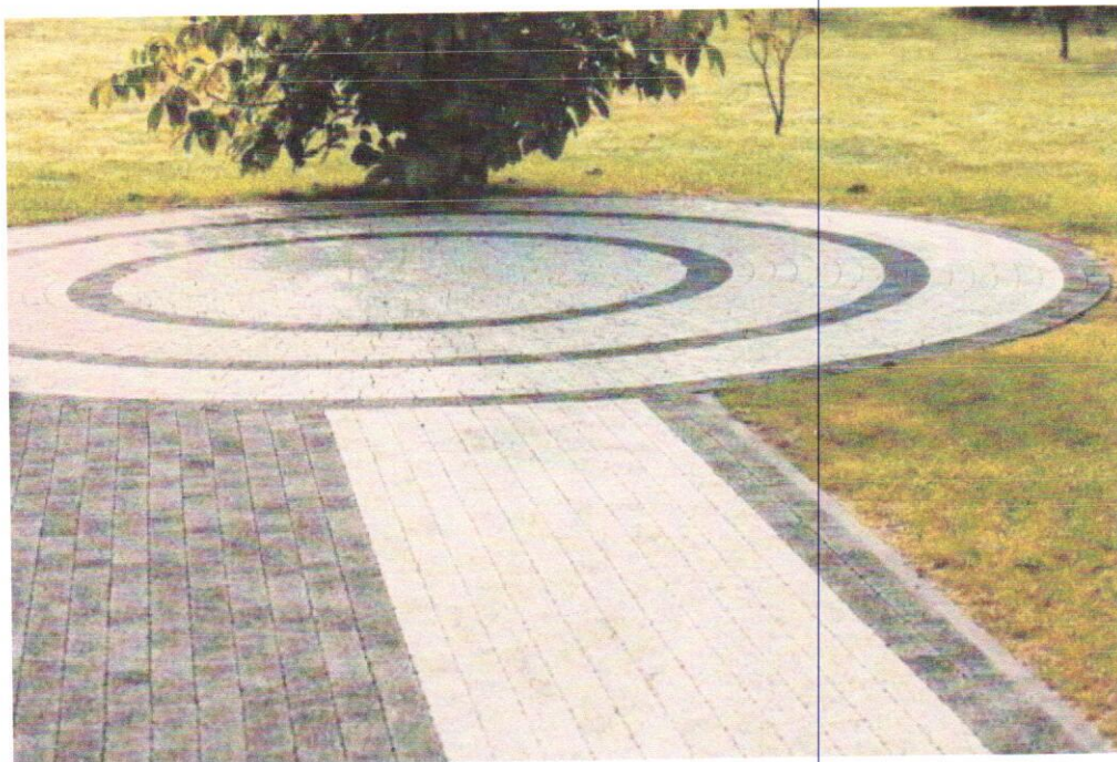
Przykład ułożenia kostki brukowej betonowej miejsce utwardzenia pod ławkami
