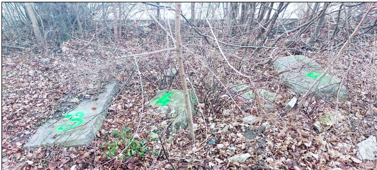
Fot.1 Elementy betonowe w północno - zachodniej części działki (do usunięcia z terenu). (źródło: inwentaryzacja 05-03-2021).
