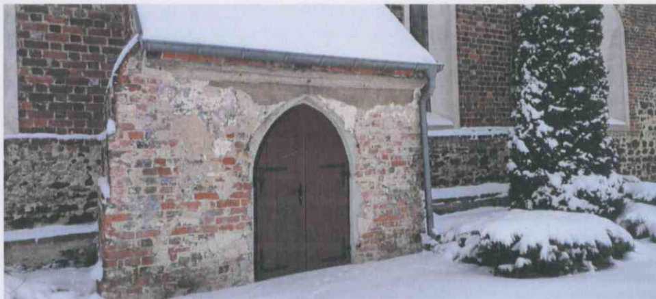
Zdj. 8 Widok części elewacji z widocznymi uzupełnieniami z zapraw cementowych.
